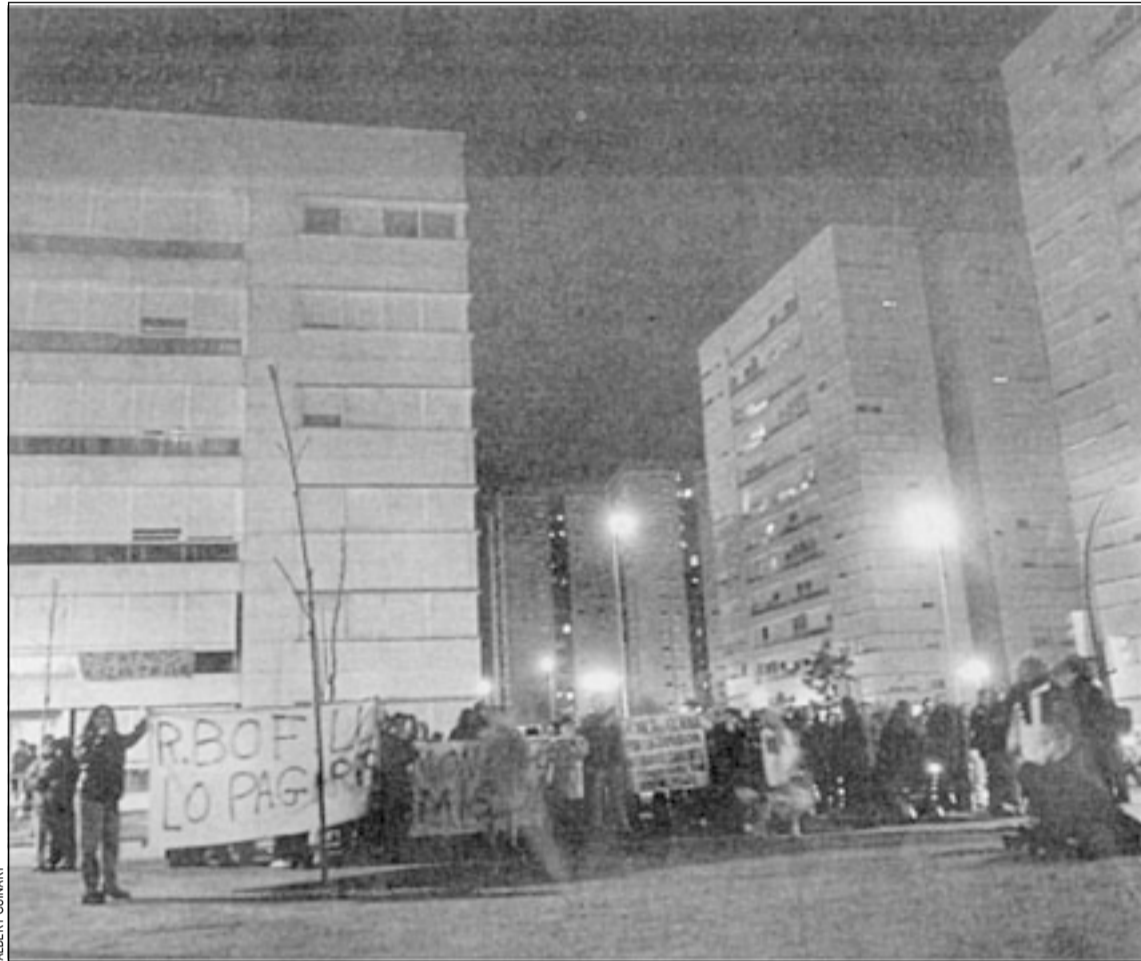
Los vecinos del Gornal se manifiestan cada viernes para exigir la reparación de sus viviendas
