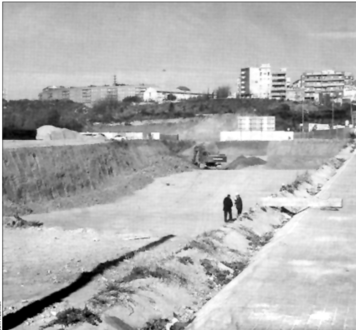
En el solar de la calle Álvarez de Castro se construirán, a partir de febrero, 154 nuevos pisos
