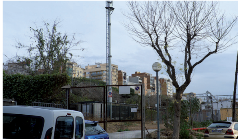
Antena ubicada entre el carrer del Treball i del Pintor Sorolla
