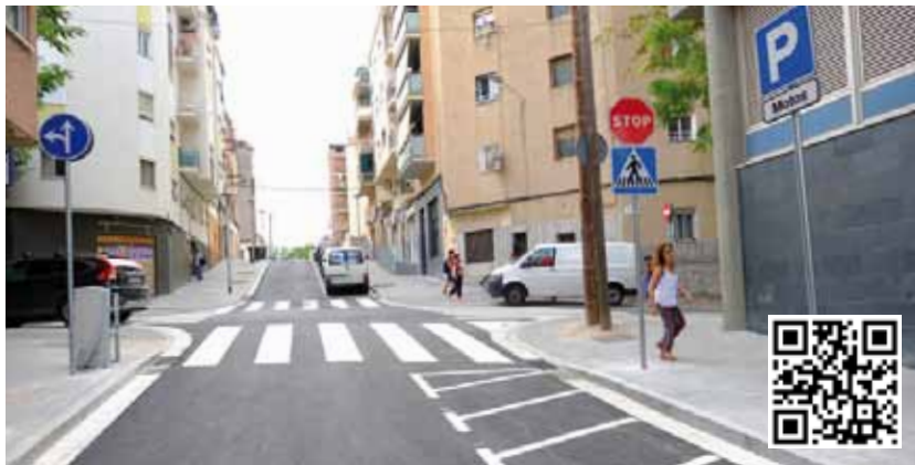
Carrer de Subur, un cop acabats els treballs d'urbanització
