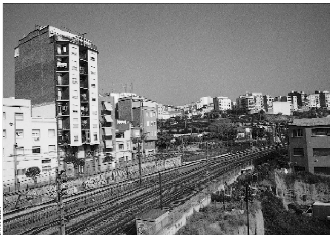
Zona en la que se construirá la estación central L'Hospitalet-la Torrassa, junto a la calle Cultura
