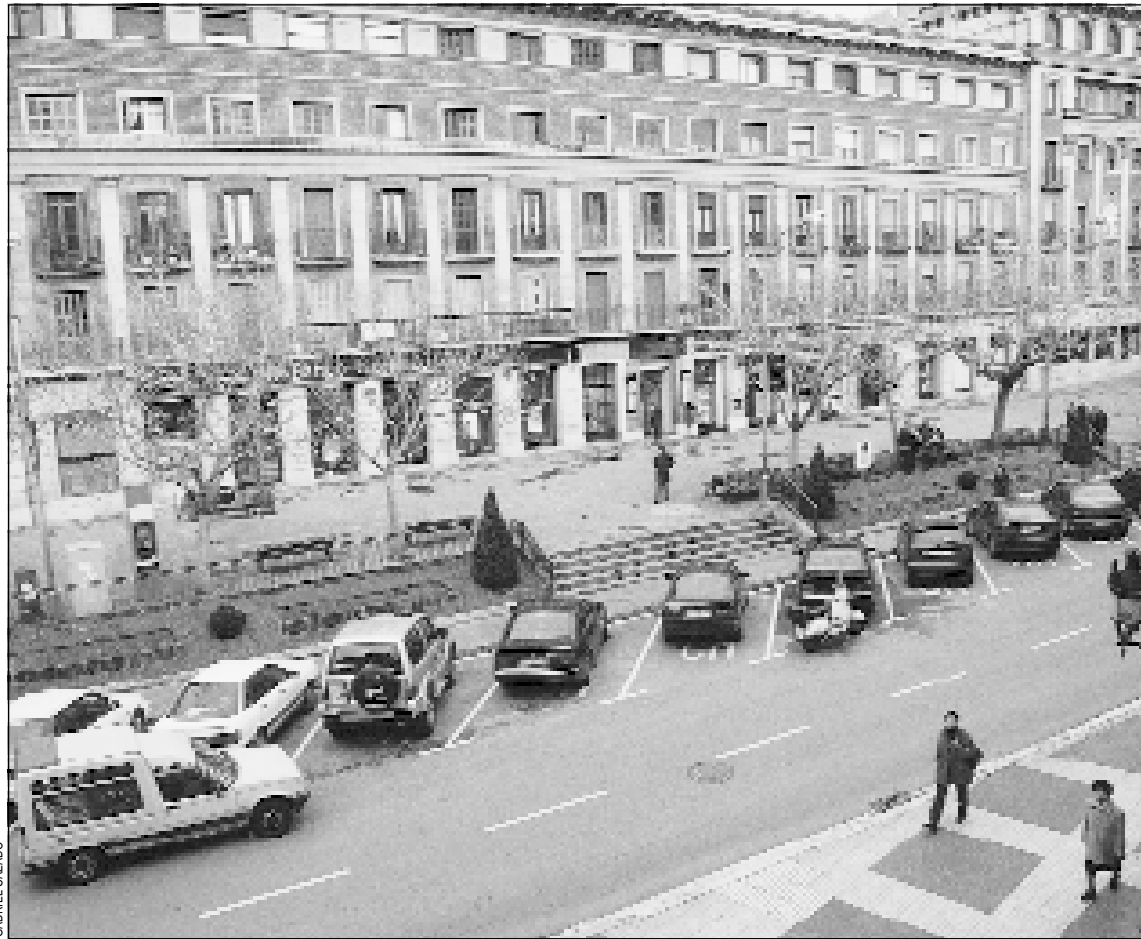
En la plaza del Ayuntamiento se construirá un aparcamiento con 250 plazas
