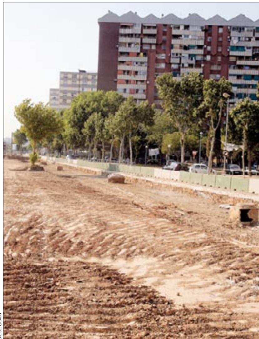
Obres a l'avinguda de la Mare de Déu de Bellvitge
