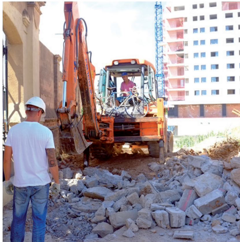
Enderroc a les obres de la Porta Nord de L'H
