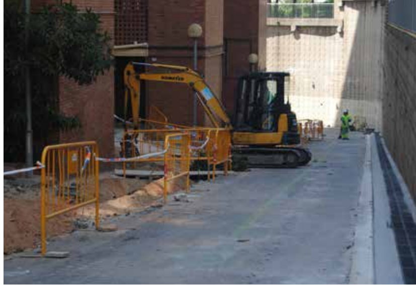
Trabajos de ampliación de la acera de la calle de Peníscola
