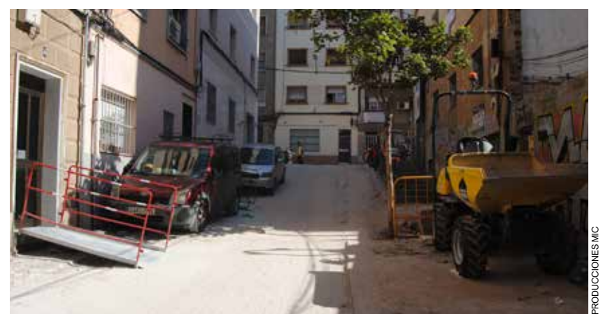
Trabajos de reforma de la calle Doctor Gregorio Marañón
