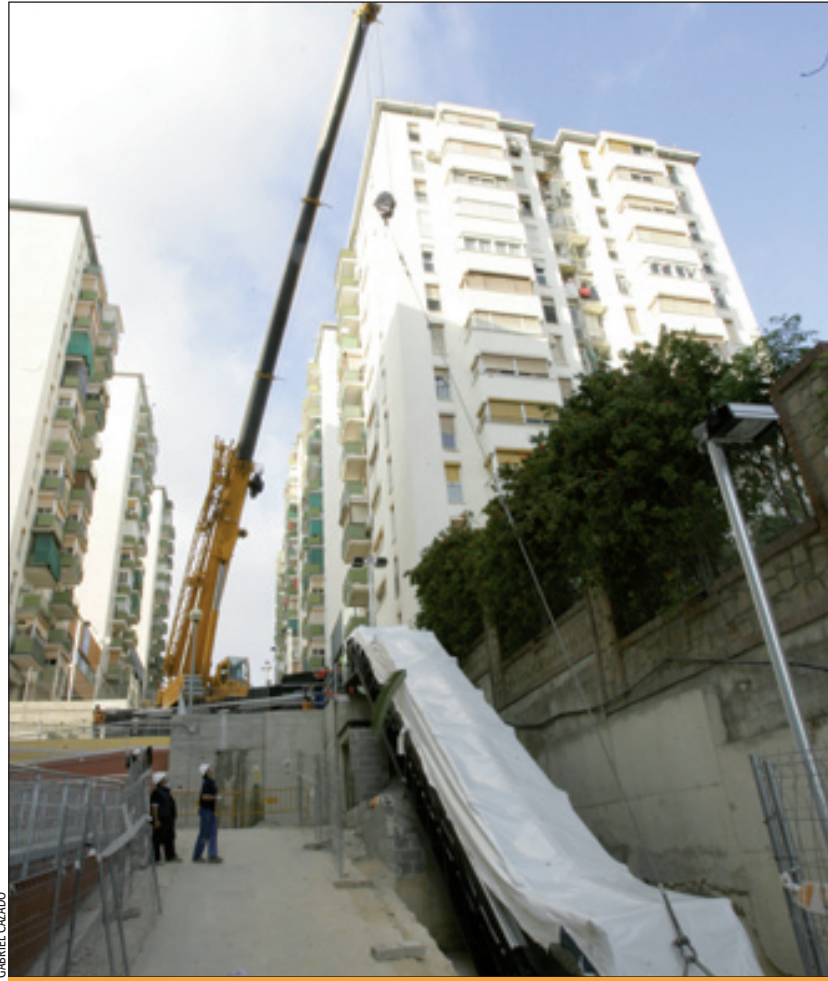
Un tram d'escales abans de la seva instal·lació
