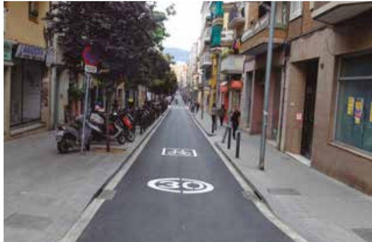
Vista del carrer del Llobregat acabat de pavimentar
