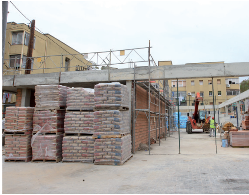
Obras del equipamiento que se construye en los Bloques Florida
