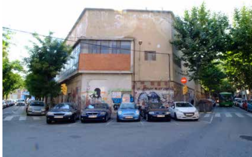
Edifici de l'Òpera, entre els carrers Francesc de Moragas i Josep Prats
