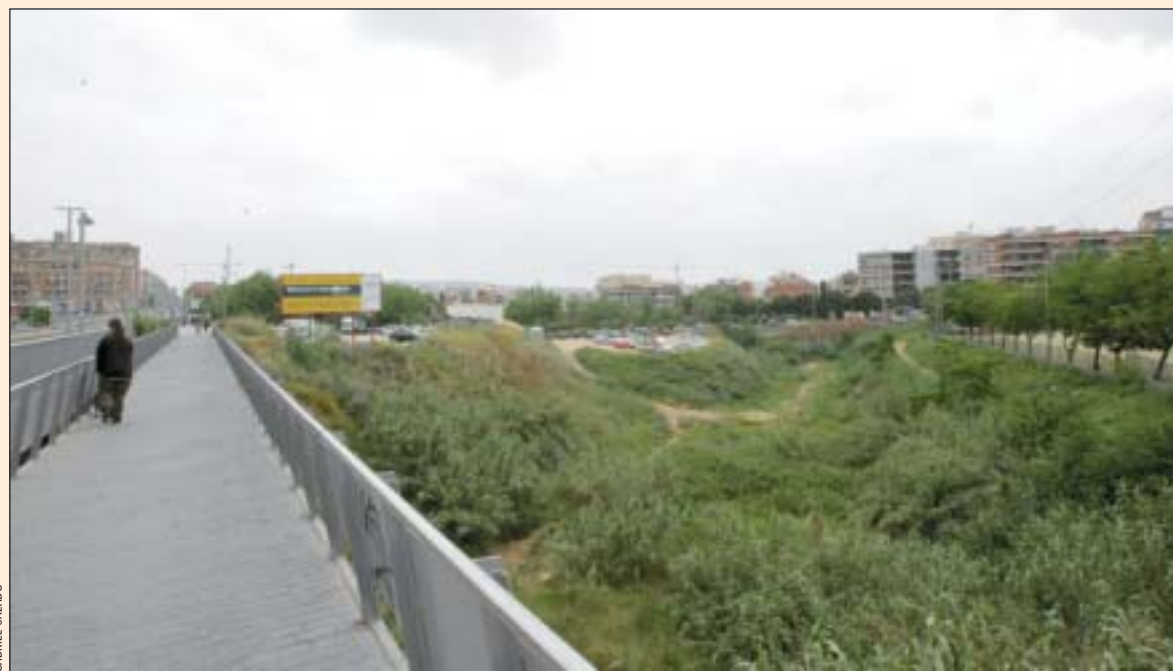
Punto de la carretera de Collblanc incluido dentro del proyecto Puerta Norte
