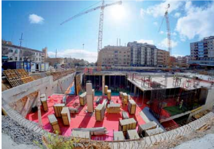
Les obres del nou Mercat ja es comencen a veure
