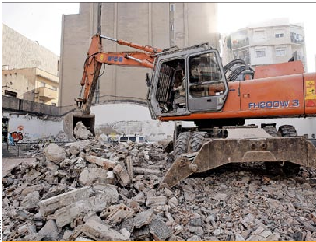
Les màquines van entrar a fer l'enderroc de l'aparcament
