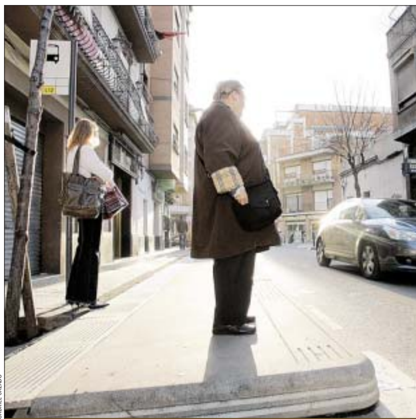
Una de les plataformes de formigó del carrer Montseny
