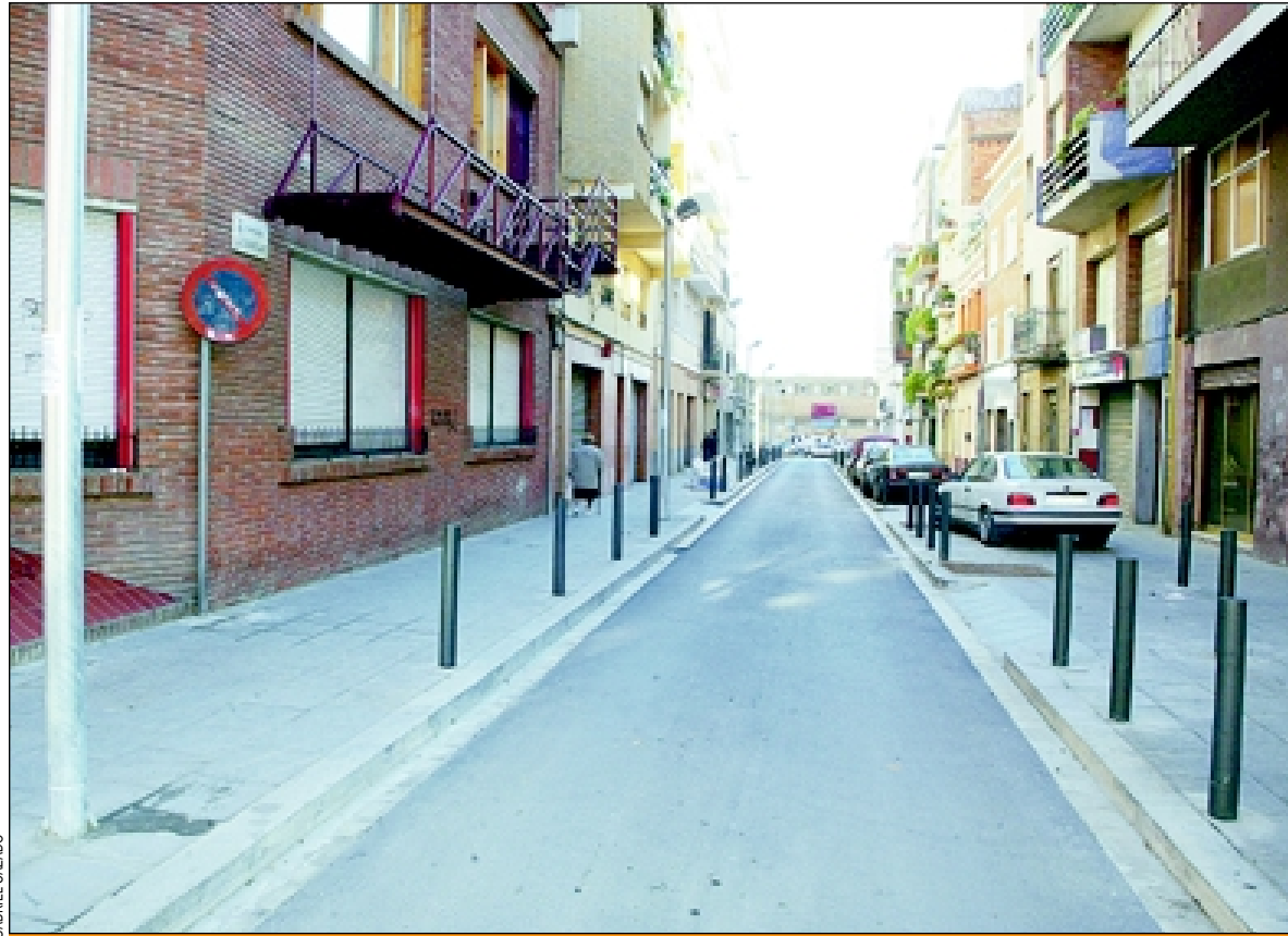
La calle Llobregat se ha remodelado para ampliar las aceras y renovar servicios
