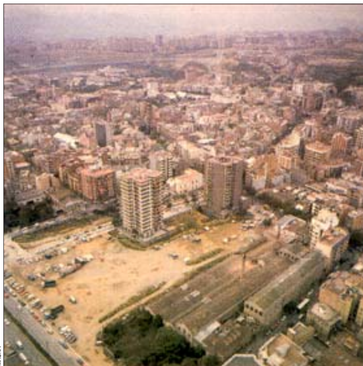
El Pla de les Rambles urbanitzarà una zona de 27.000 m 2
