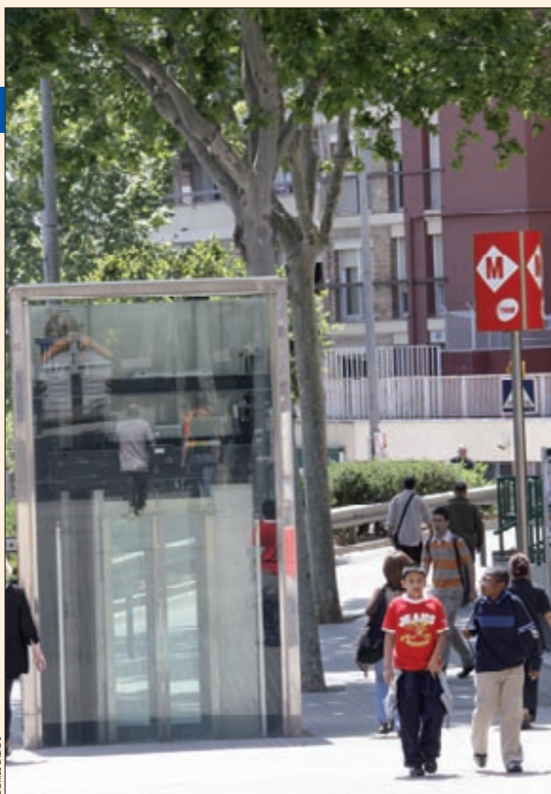
Ascensor en la parada de Metro de Can Serra
