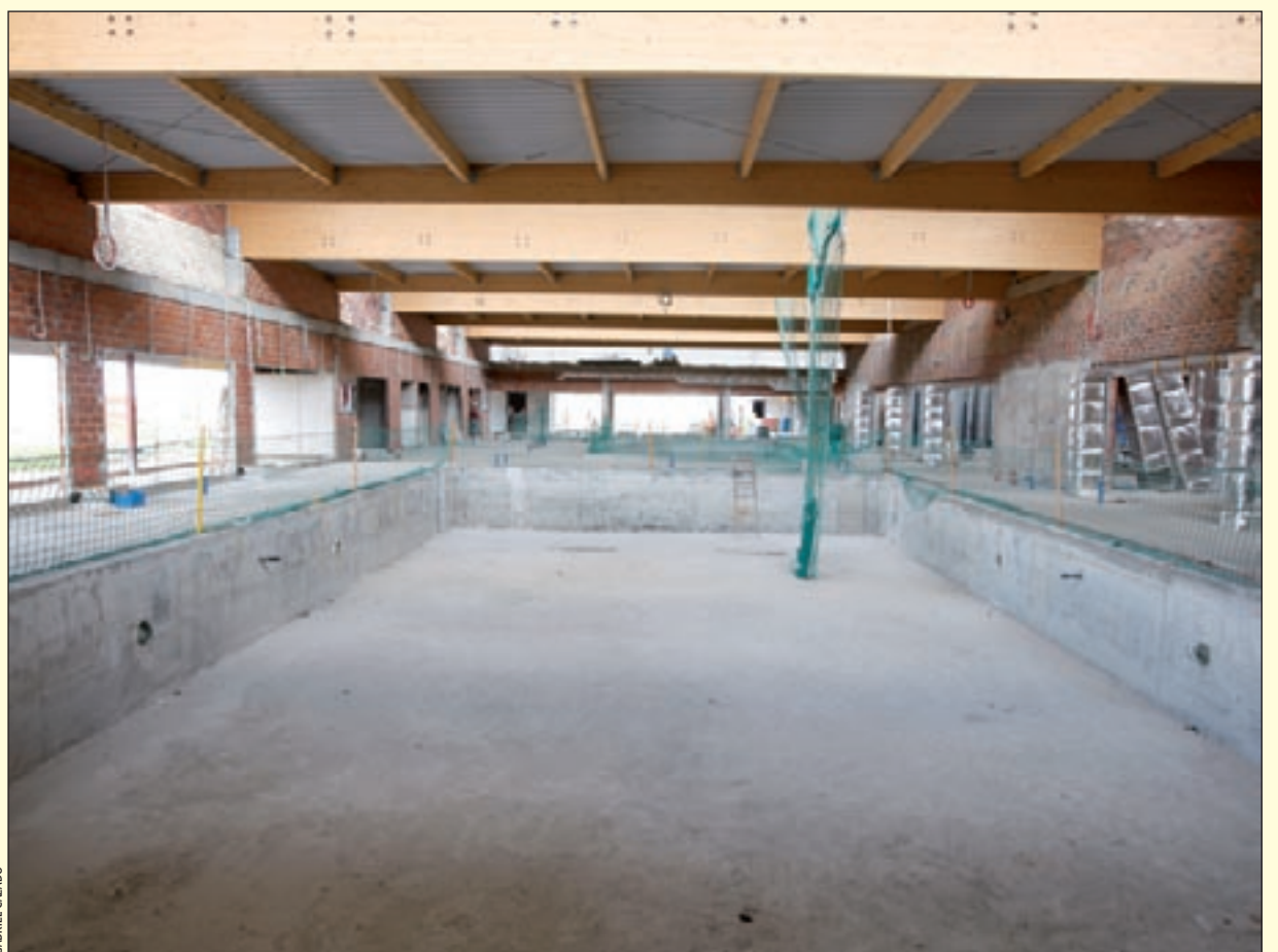
Detalle de las obras de la piscina del polideportivo del barrio
