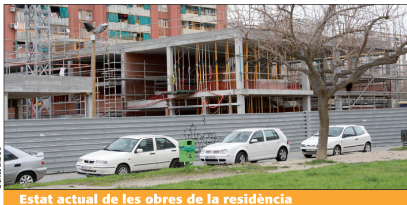
Estat actual de les obres de la residència
