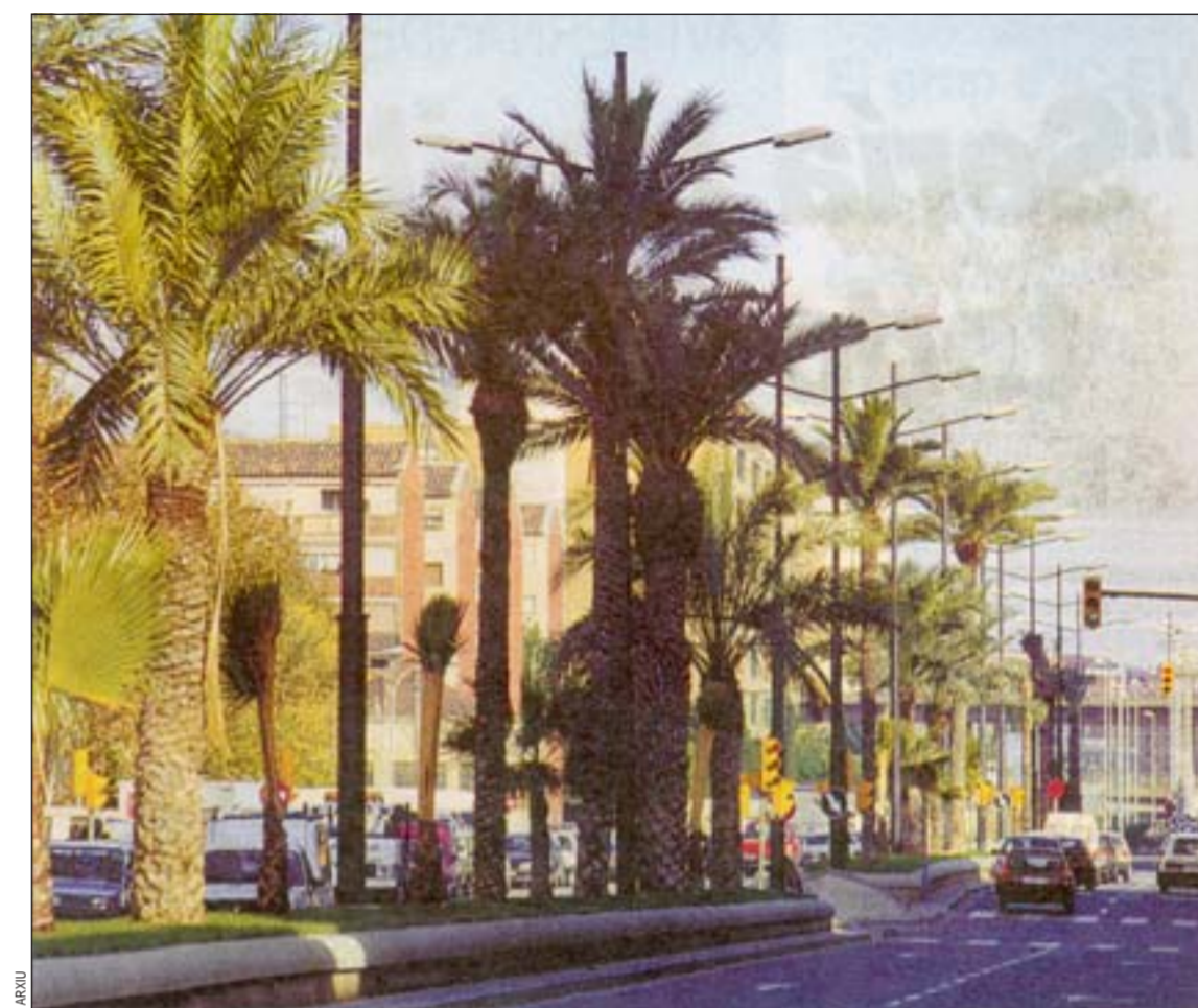
La urbanización de la avenida del Carrilet ha permitido recuperar una vía esencial para la ciudad
