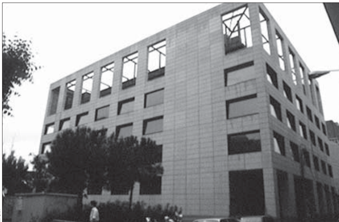
Este nuevo edificio, situado en la calle Mediodía, 5-9, permitirá mejorar la atención al público
