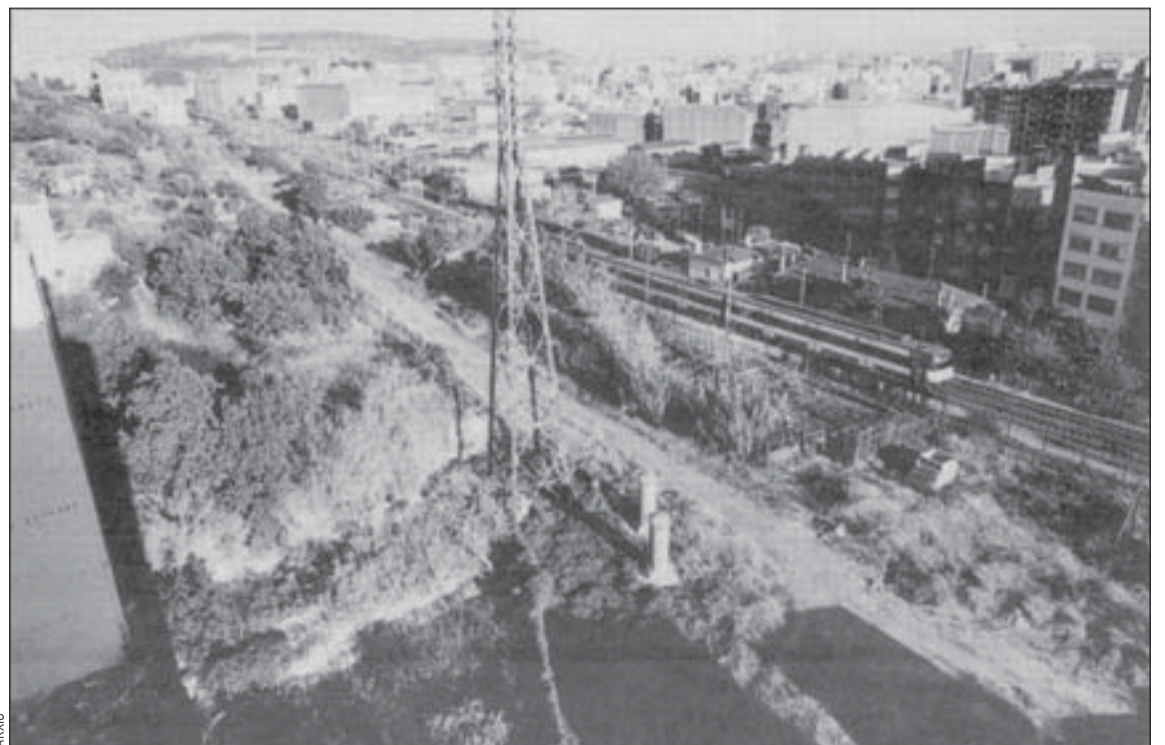
El futuro parque de la Torrassa se pone en marcha con las obras del colector aprobadas en Pleno
