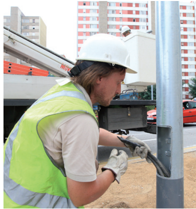
Reparación de una farola
