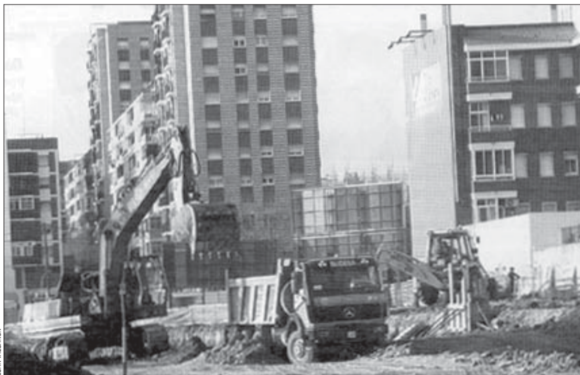
Les obres del PERI Amadeu Torner afecten una superfície de més de 20.000 metres quadrats
