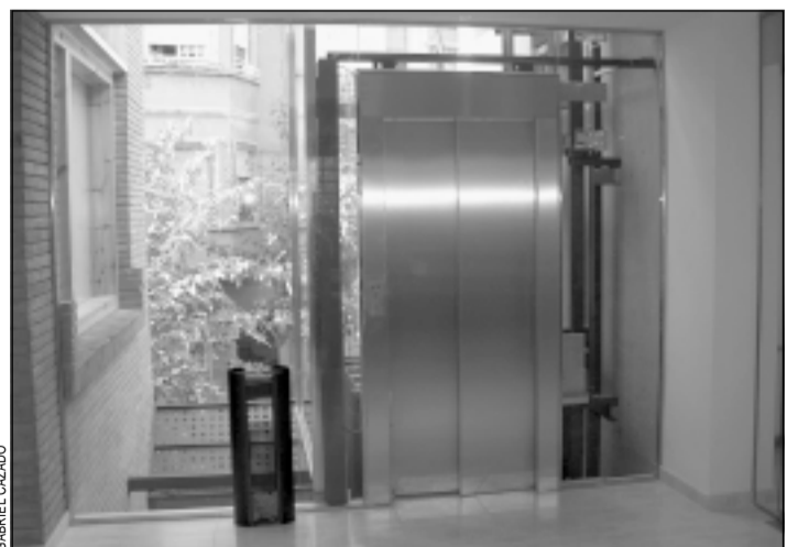
Las nuevas instalaciones facilitan el acceso
