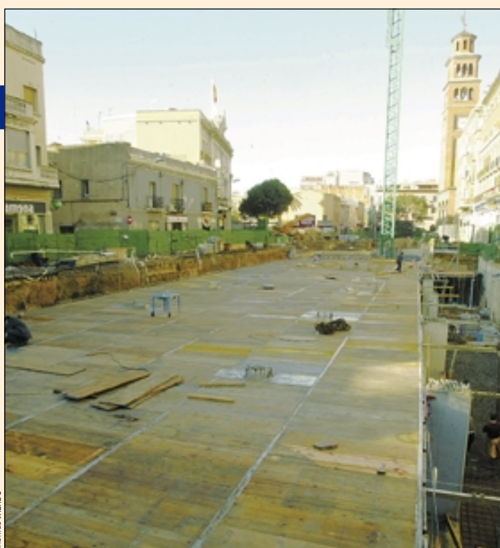
Estado actual de las obras
