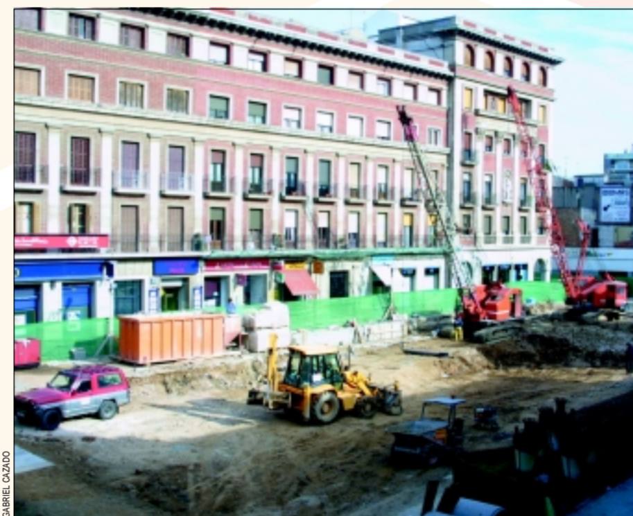
Obras para la reordenación de la plaza del Ayuntamiento
