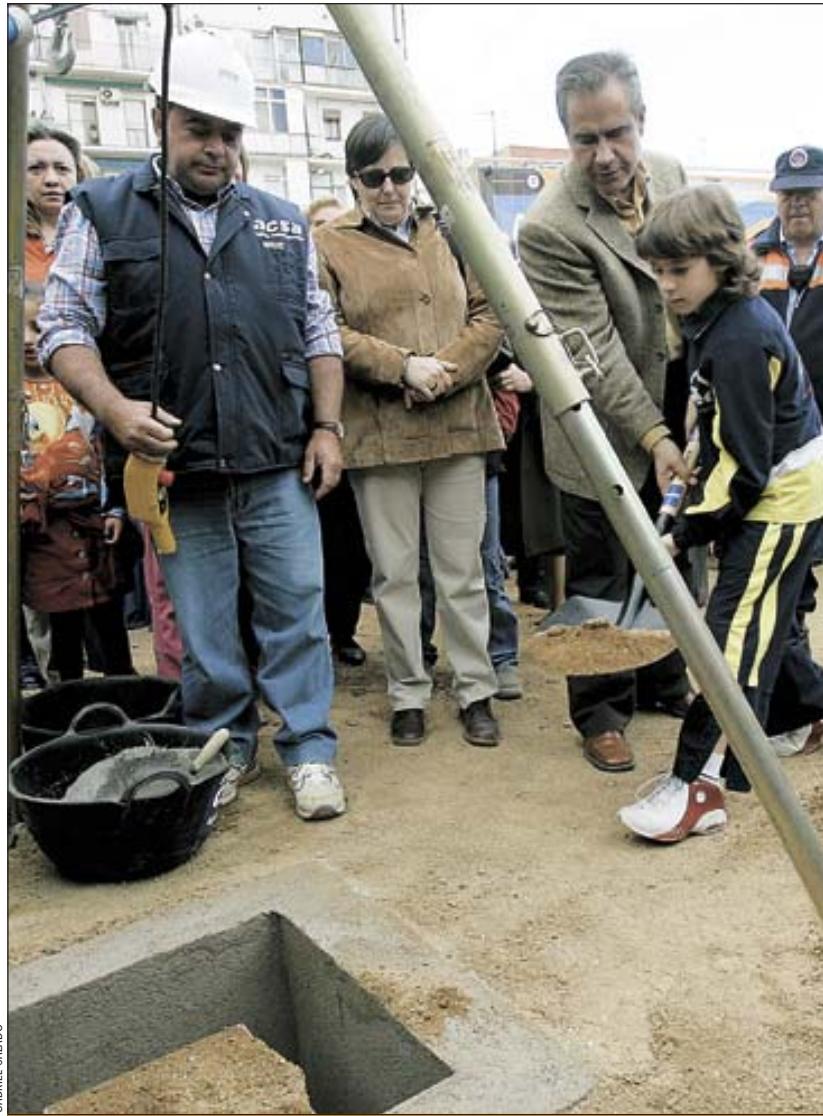
Acte de col·locació de la primera pedra del pàrquing
