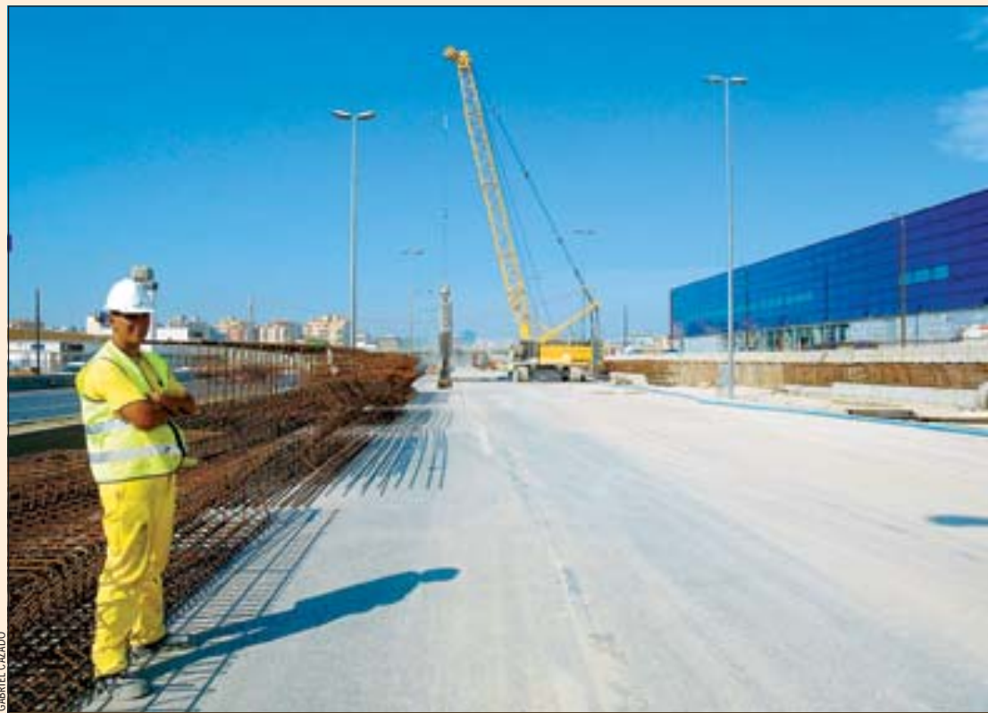
Estado de las obras de reforma de la Granvia en la calzada central
