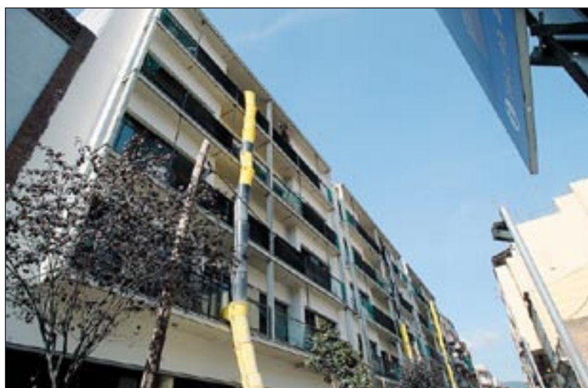
Nuevo edificio de protección en la calle del Llobregat
