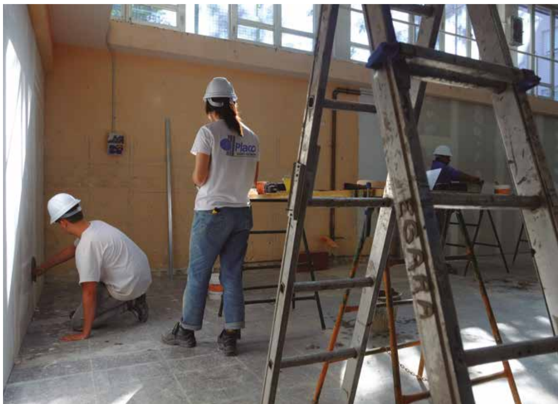
Classe de la família de construcció a l'Institut Provençana
