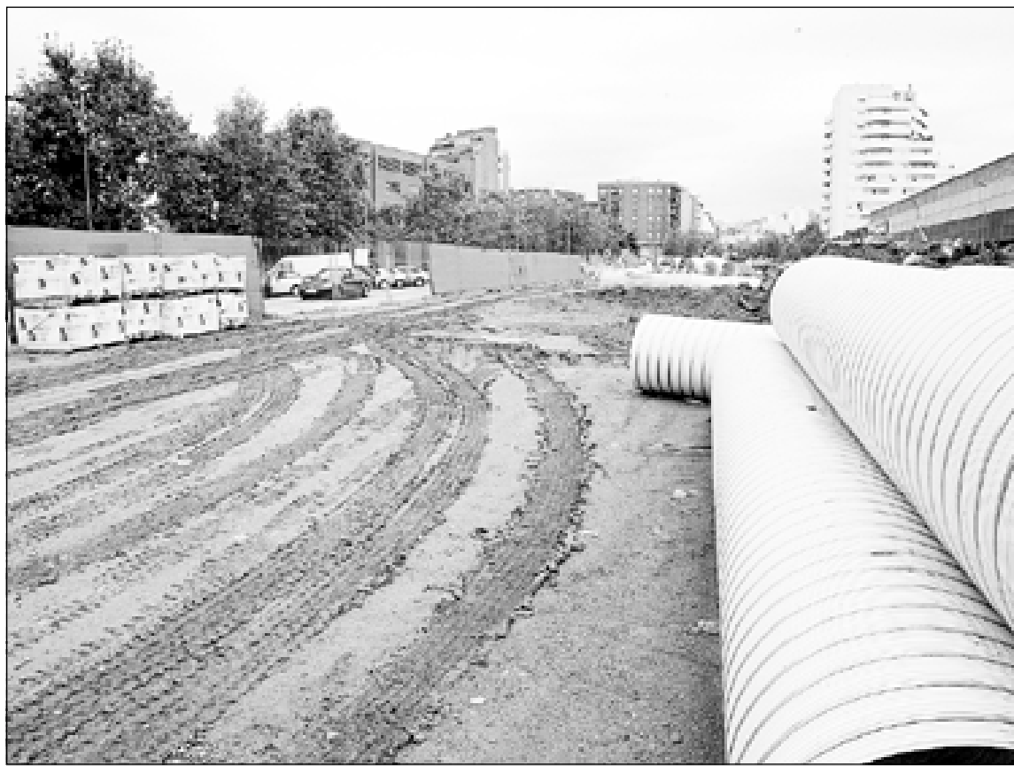
Les obres de la nova rambla s'han iniciat amb l'ampliació del col·lector
