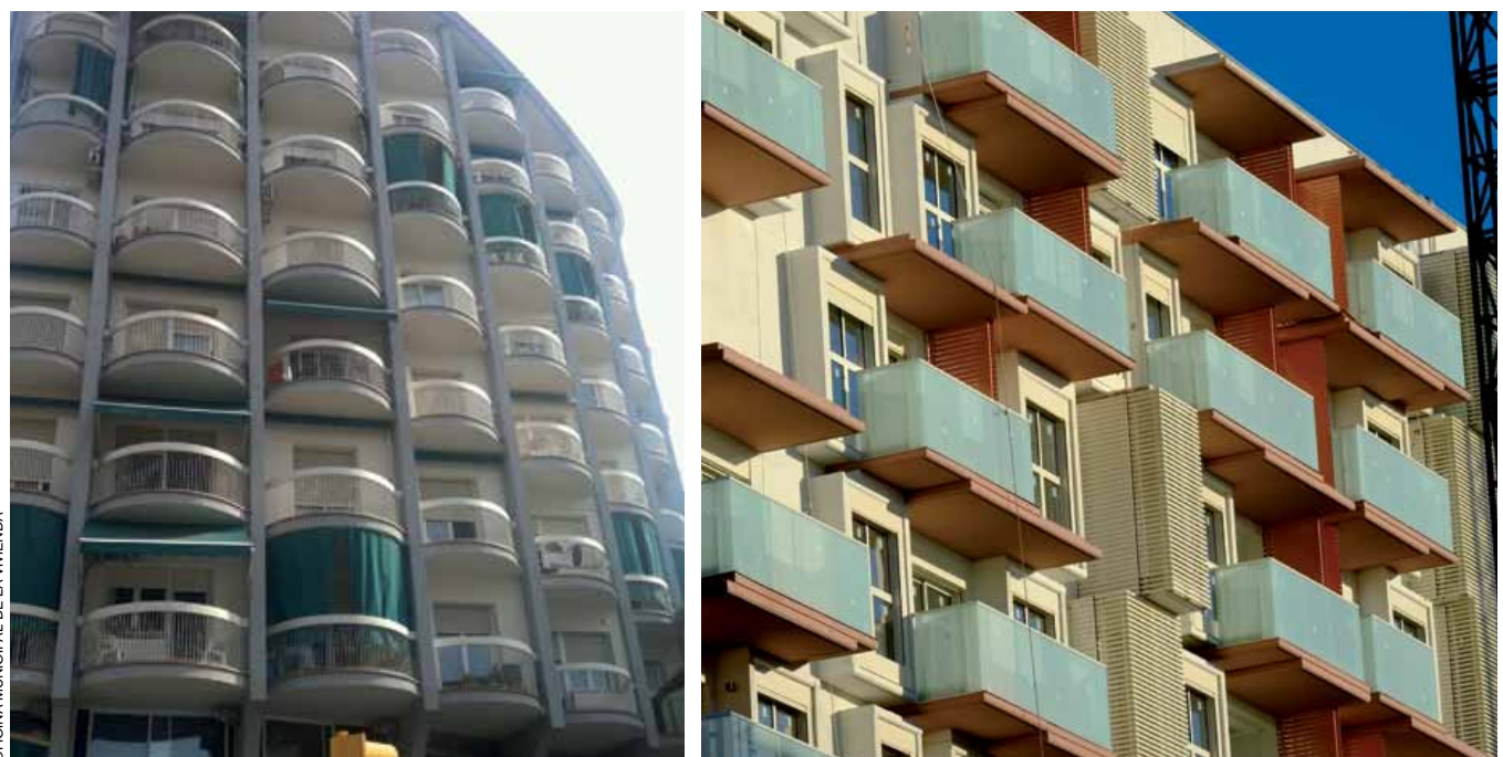
Fachada reformada en Santa Eulàlia y viviendas de protección que se están construyendo en la Remunta
