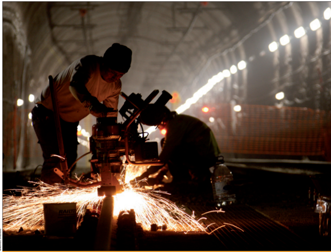
Obres de construcció de la nova estació d'Ernest Lluch del Metro
