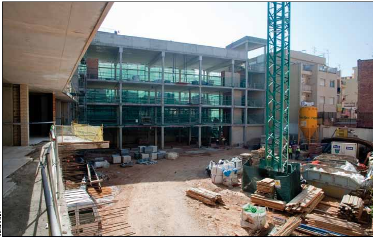
El nou CEIP Màrius Torres, actualment en construcció, fruit del conveni inicial
