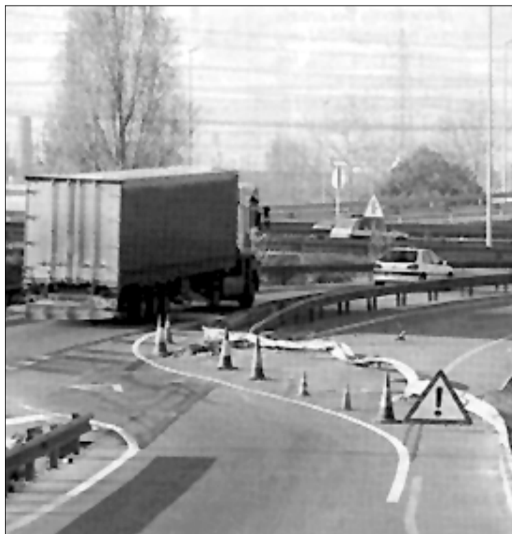
El 28 de enero se cerró el enlace entre la Gran Vía y la ronda
