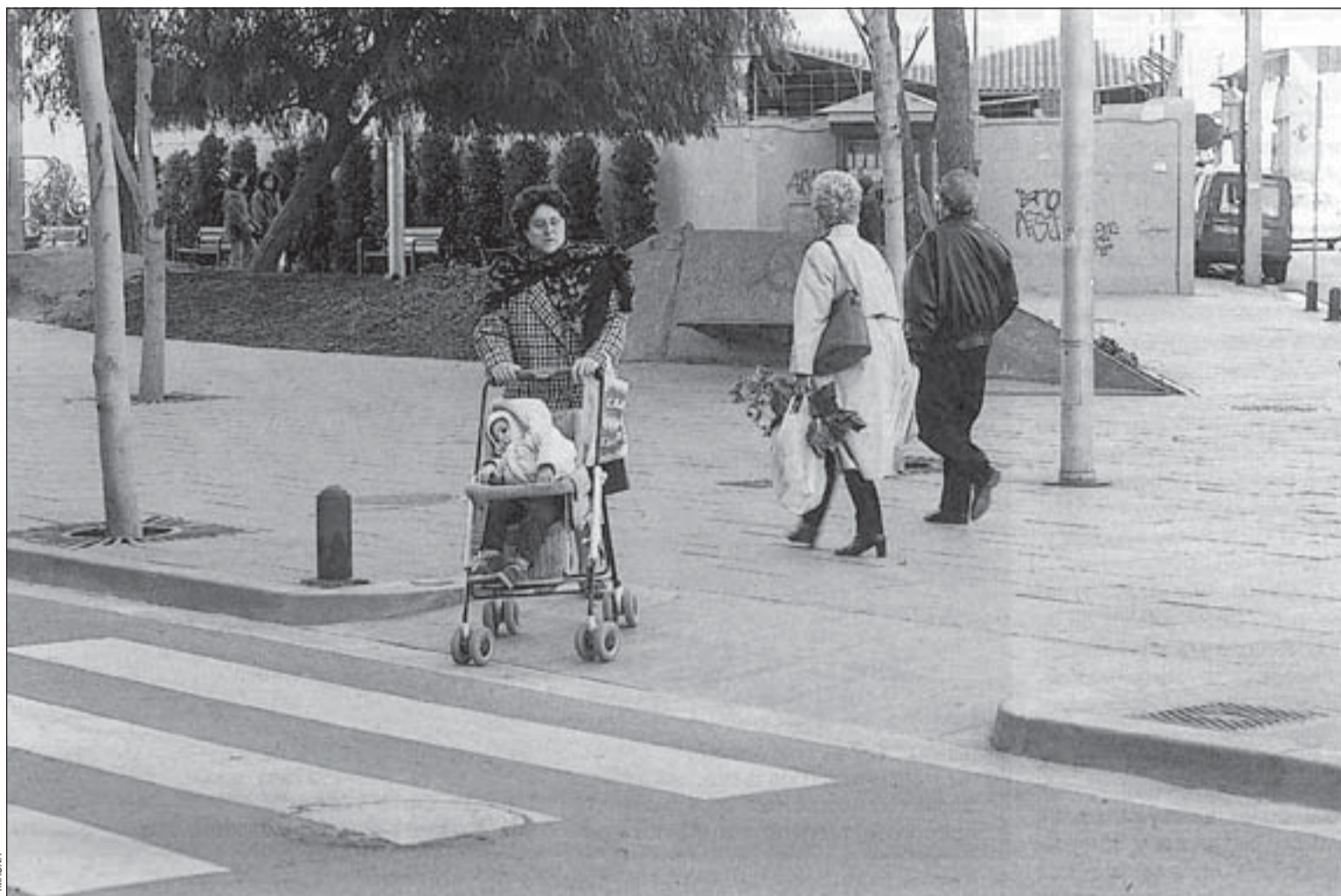
La segunda fase de la avenida del Carrilet es una obra emblemática en la lucha contra las barreras arquitectónicas
