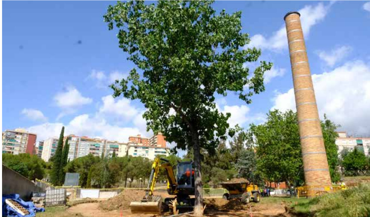
Zona d'obres al voltant de l'única xemeneia de les antigues bòbiles que es conserva al parc
