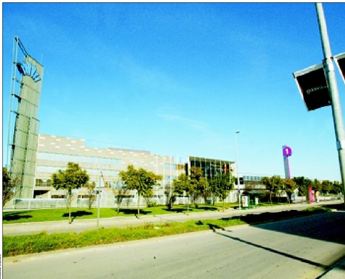
Instalación de la Fira en Granvia L'Hospitalet
