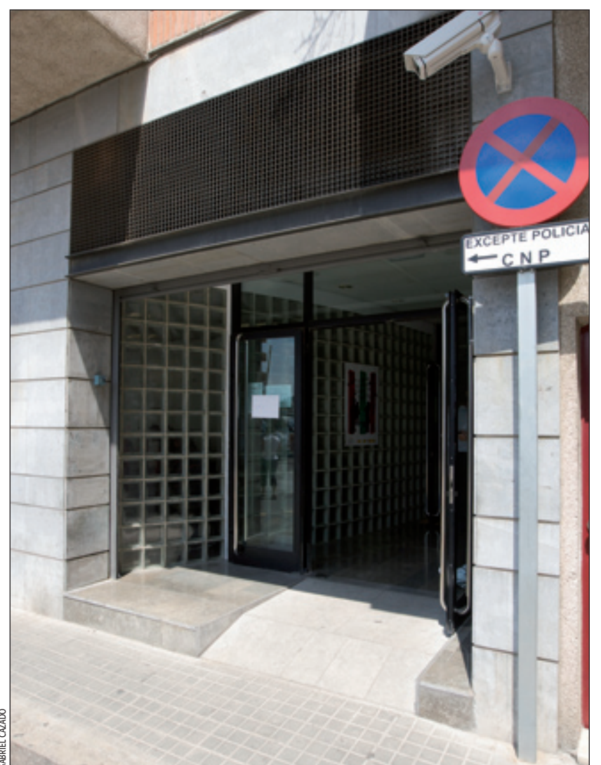
Instal·lacions provisionals de la comissaria de L'H
