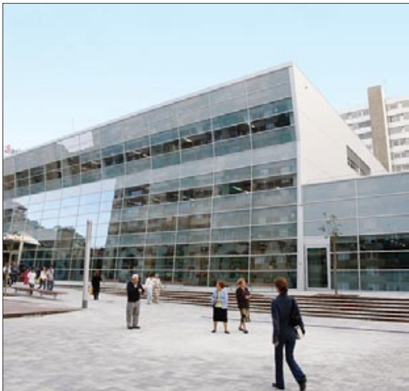
Façana principal del nou equipament
