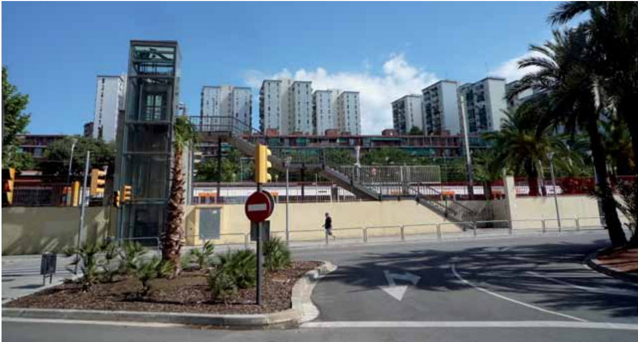
L'actual ascensor sobre les vies s'aprofitarà per fer accessible l'estació del Metro
