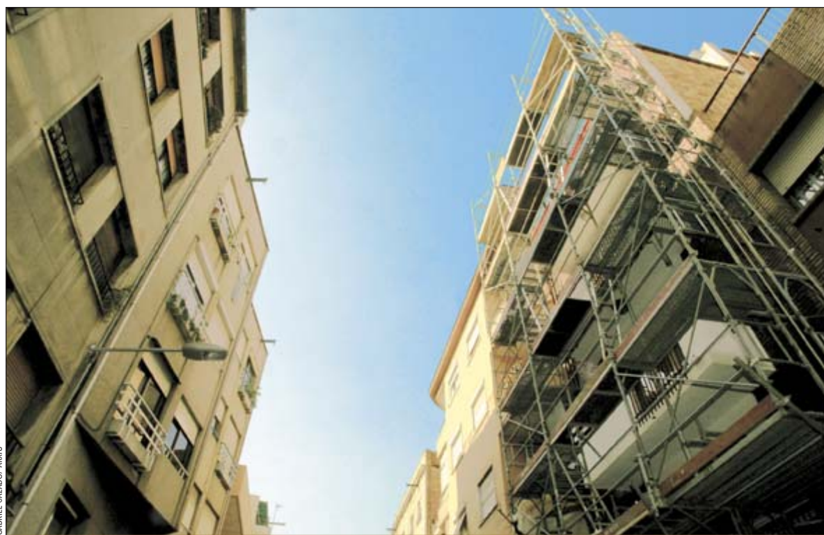
Edificios en proceso de reforma en Collblanc-la Torrassa
