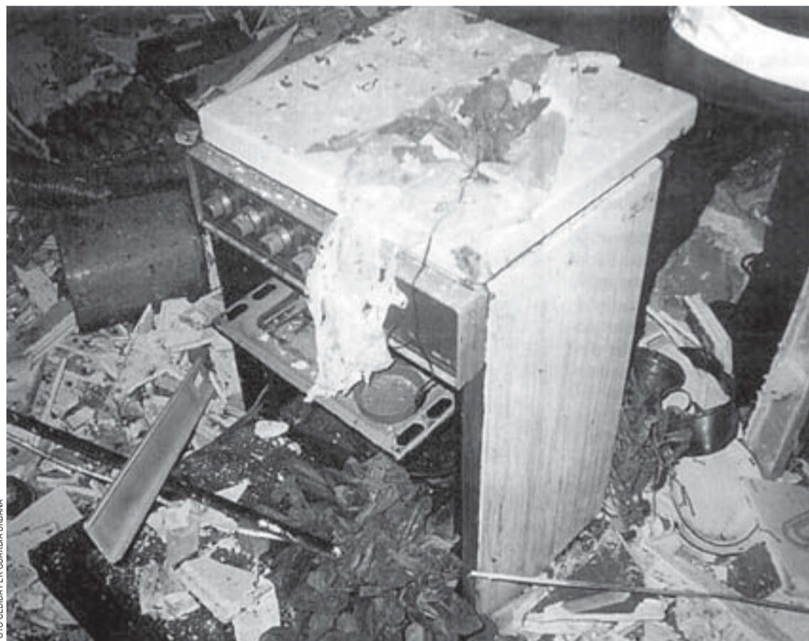
Los destrozos causados por una explosión de gas en un domicilio ofrecen imágenes como ésta
