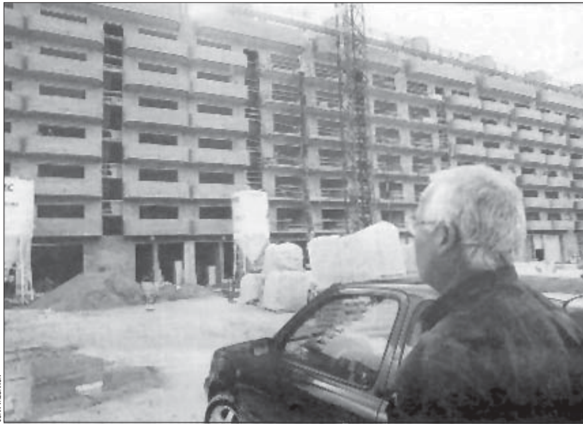
En el PERI Atasa, en Santa Eulàlia, se están construyendo 115 nuevas viviendas
