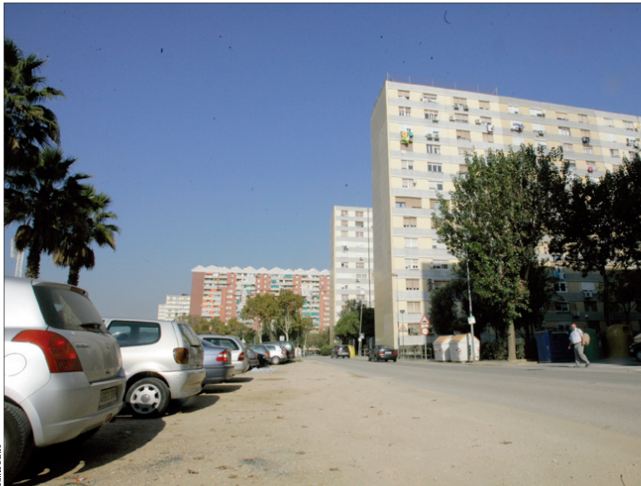
La reforma contempla habilitar zones d'aparcament en superfície
